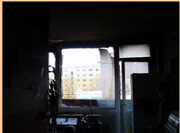
Spoušť po požáru pohledem z obývacího pokoje.
